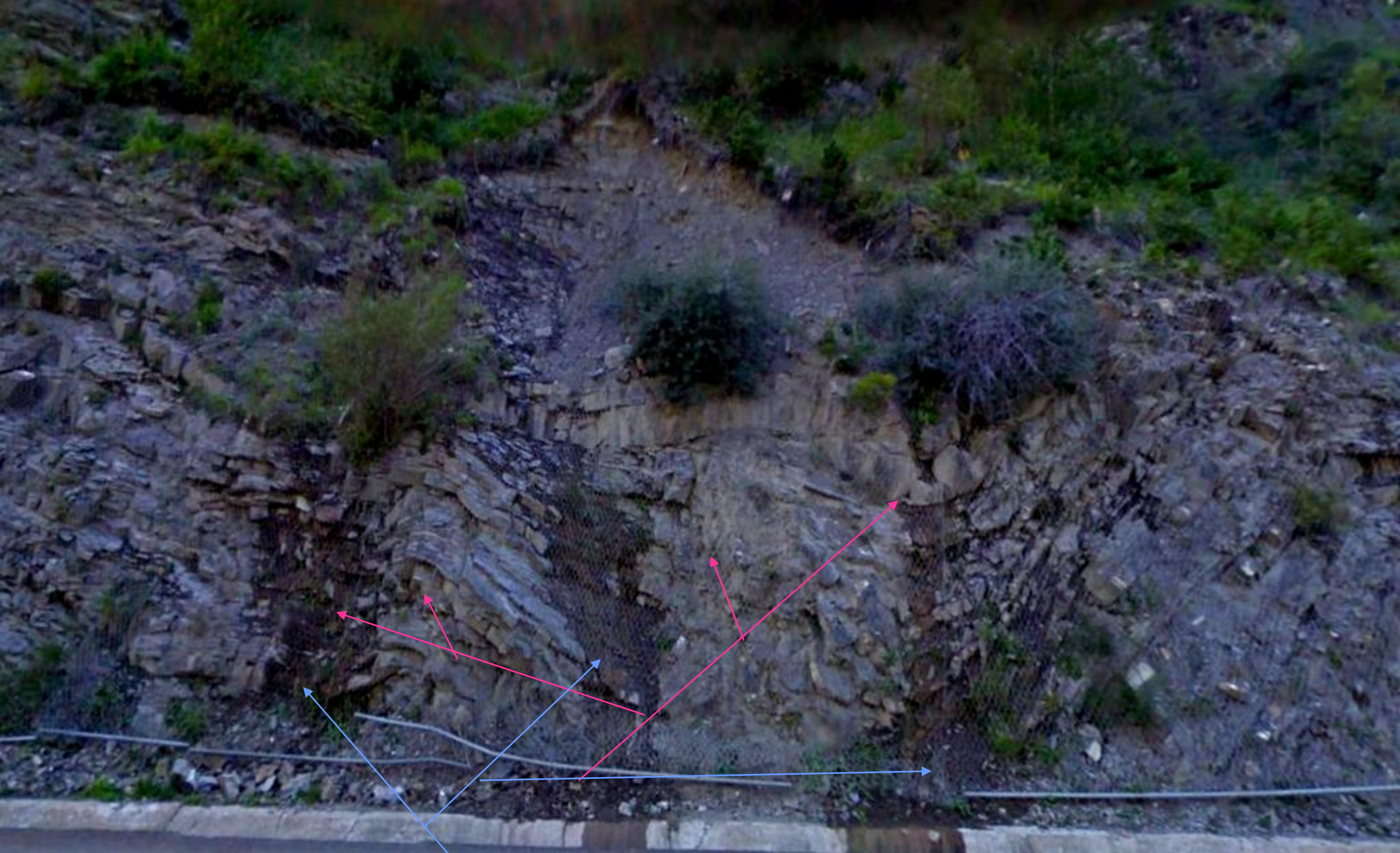
Complejidad estructural y fluencia de agua en materiales del Cretácico Sup. Al S. de Poltuara. Autopista. Hojas de Sallent y Biescas
