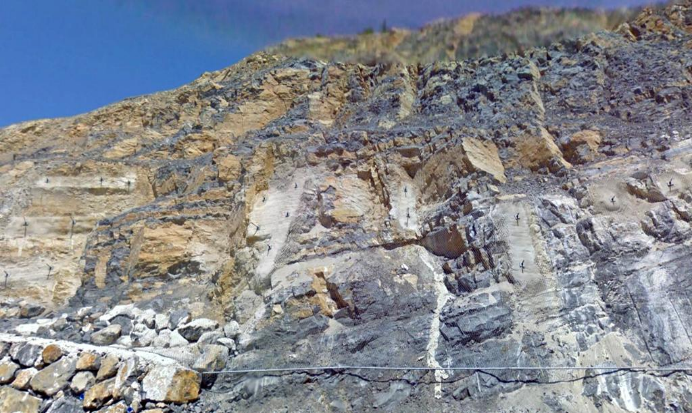
Estabilizado de talud en las calcarenitas con glauconita en la base, del Eoceno, Terciario. SW Hoja de Navascues.
